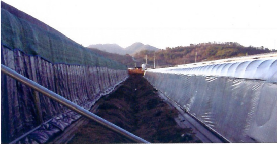
하우스 한 동당 거리가 4m 70cm, 앞 동 하우스 높이는 3m 30cm로 처음부터 그렇게 시공, 해가 질 때까지 하우스 내부 골고루 빛이 들어오게끔 설계되어 있는 온실 모습.
